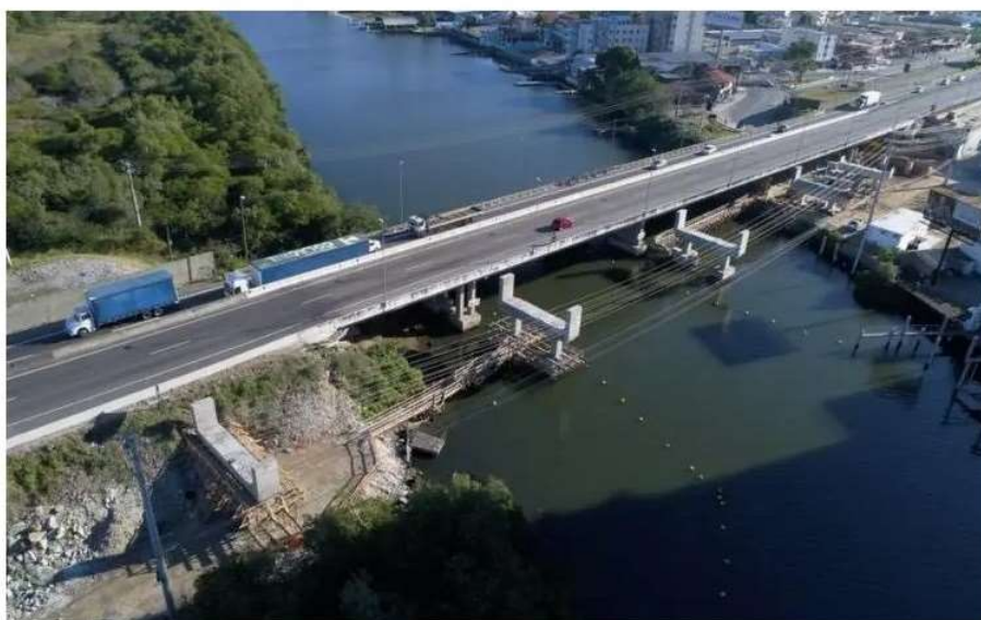
Ponte sobre o Rio Camboriú em construção (Foto: Arteris)
