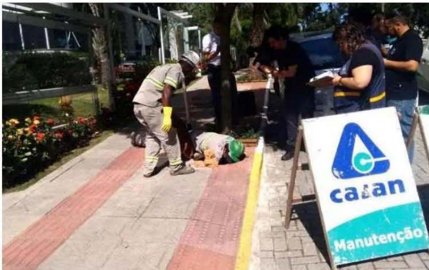
Fiscalização já ocorreu no bairro Itacorubi (Foto: Divulgação / Casan)
