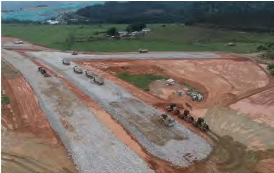
Obras do contorno viário da Grande Florianópolis (Foto: Divulgação/ Arteris)
